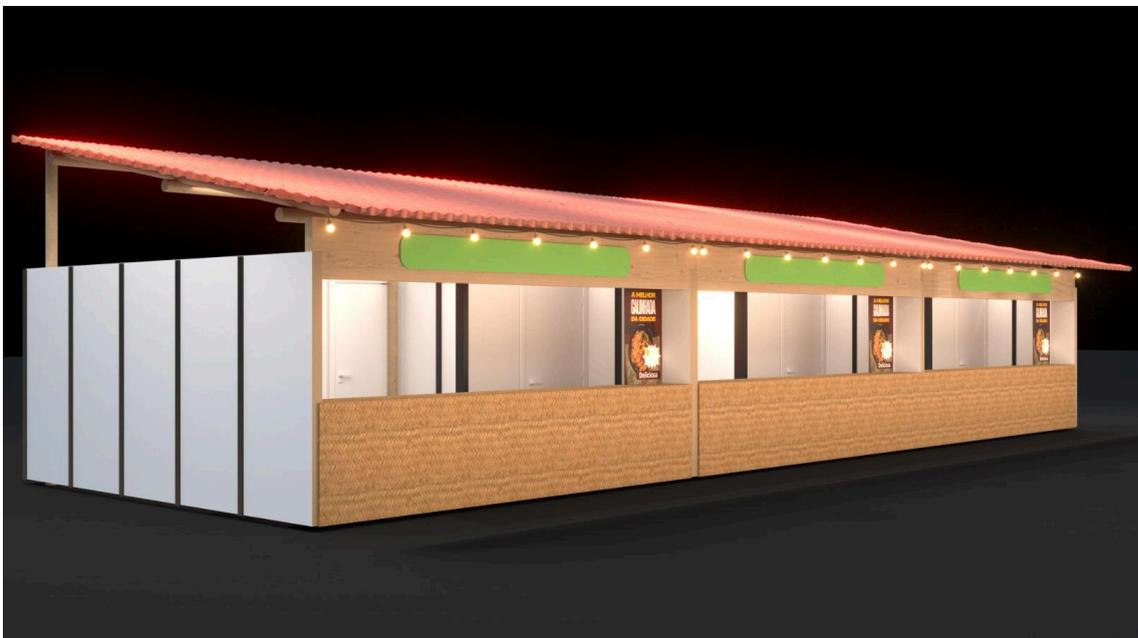
3.4 Ranchos estruturados em pontaletes de eucalipto com quatro colunas, depósito de fundo estruturado em madeira com passagem com cobertura em tecido, três faces em balcão com acabamento frontal em esteira de palha ignifugada, comunicação visual em mdf impresso recortado em formato especial com aplicação de letras recorte em pvc, com cobertura estruturada em pontalete e telhado em telhas de pvc – Medidas: 5,00 x 5,00 x 3,00 (h); Medidas comunicação visual: 2,75 x 0,20 (h) – 7 UNIDADES
